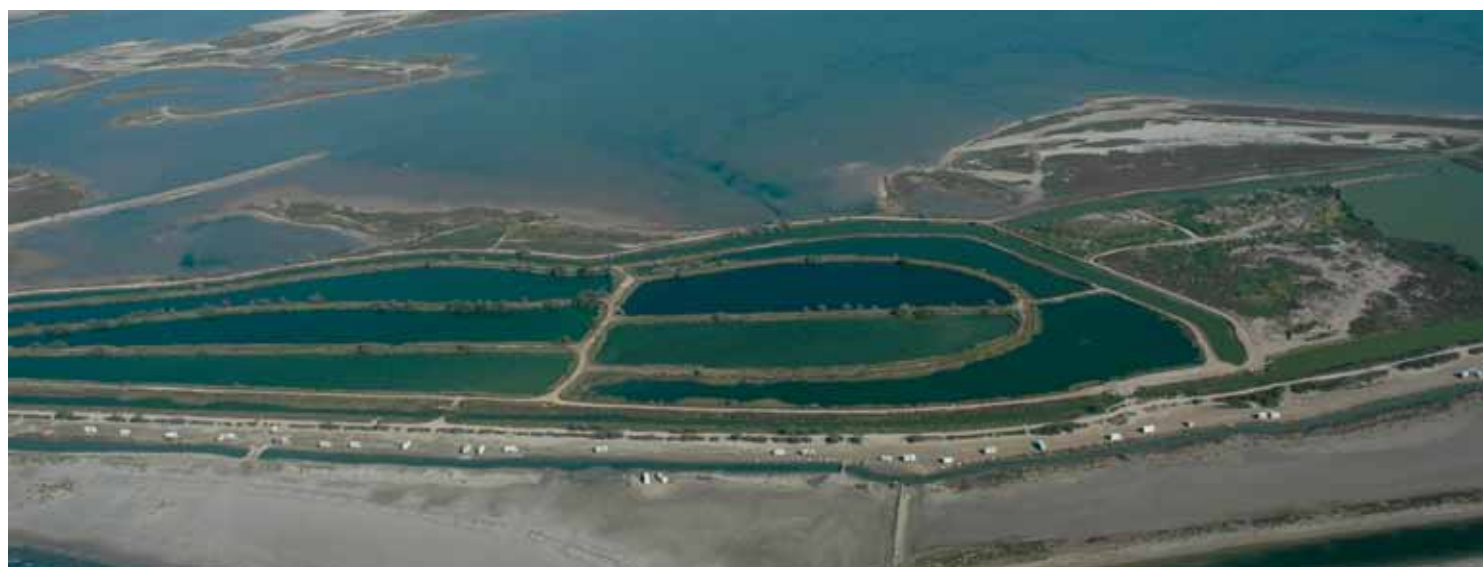
Station d'épuration par lagunage des Saintes-Maries-de-la-Mer © Opus Species / PNRC
